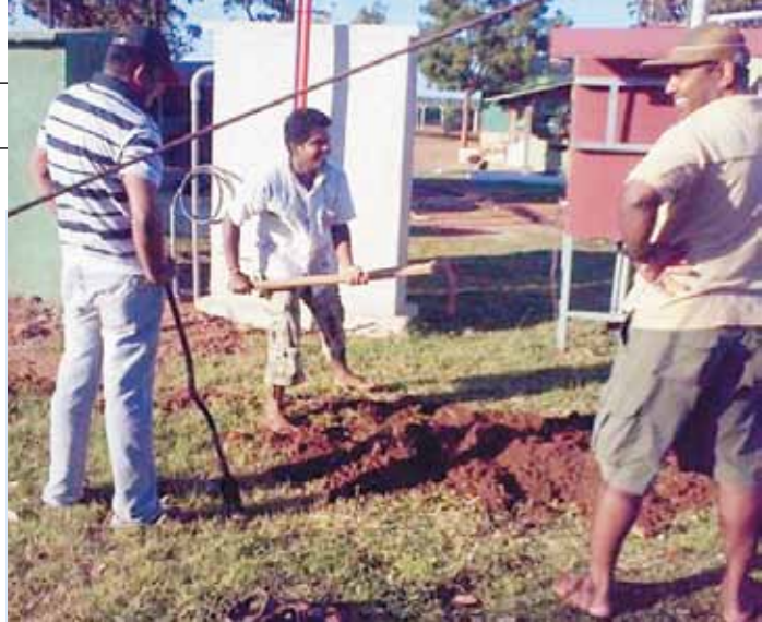
Construction de stations de base en dépit du sol et du terrain défavorables
